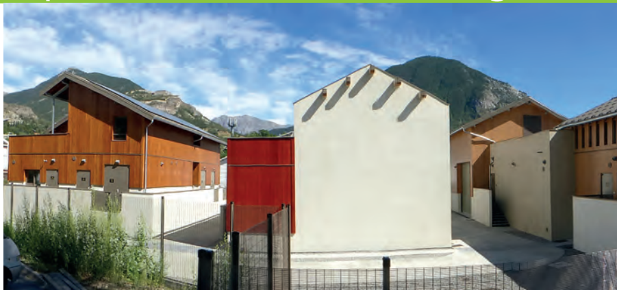
Bâtiments du Poste source
