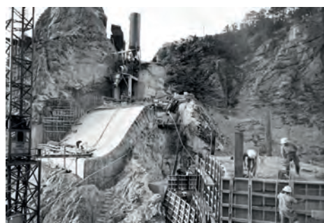
La construction du barrage/1964-1965
