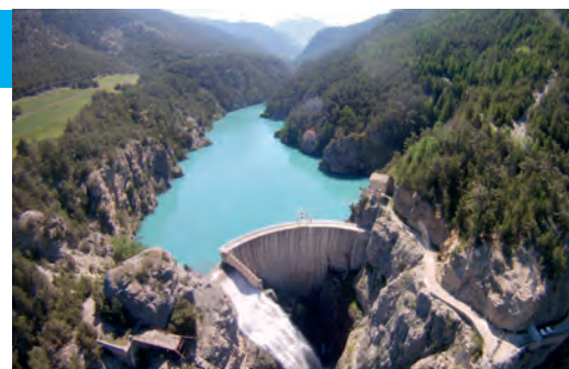
Le barrage de Pont Baldy
