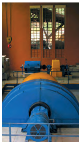
L'usine de Pont Baldy
